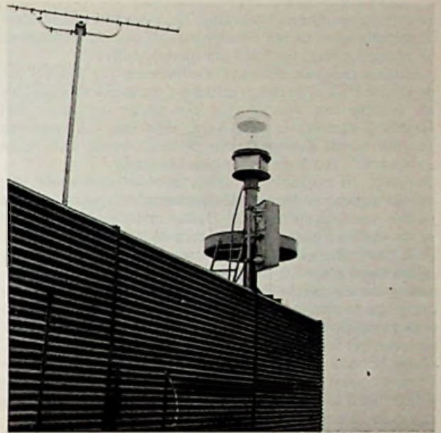
Afb. 1. Rondstraler voor band VI (12GHz) in proefopstelling in West-Berlijn
