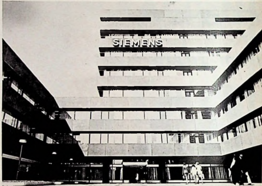
Het nieuwe hoofdkantoor van Siemens Nederland N.V. bestaat uit een drietal met elkaar verbonden gebouwen. De kantoorverdiepingen zijn ingericht als kantoorlandschap.
